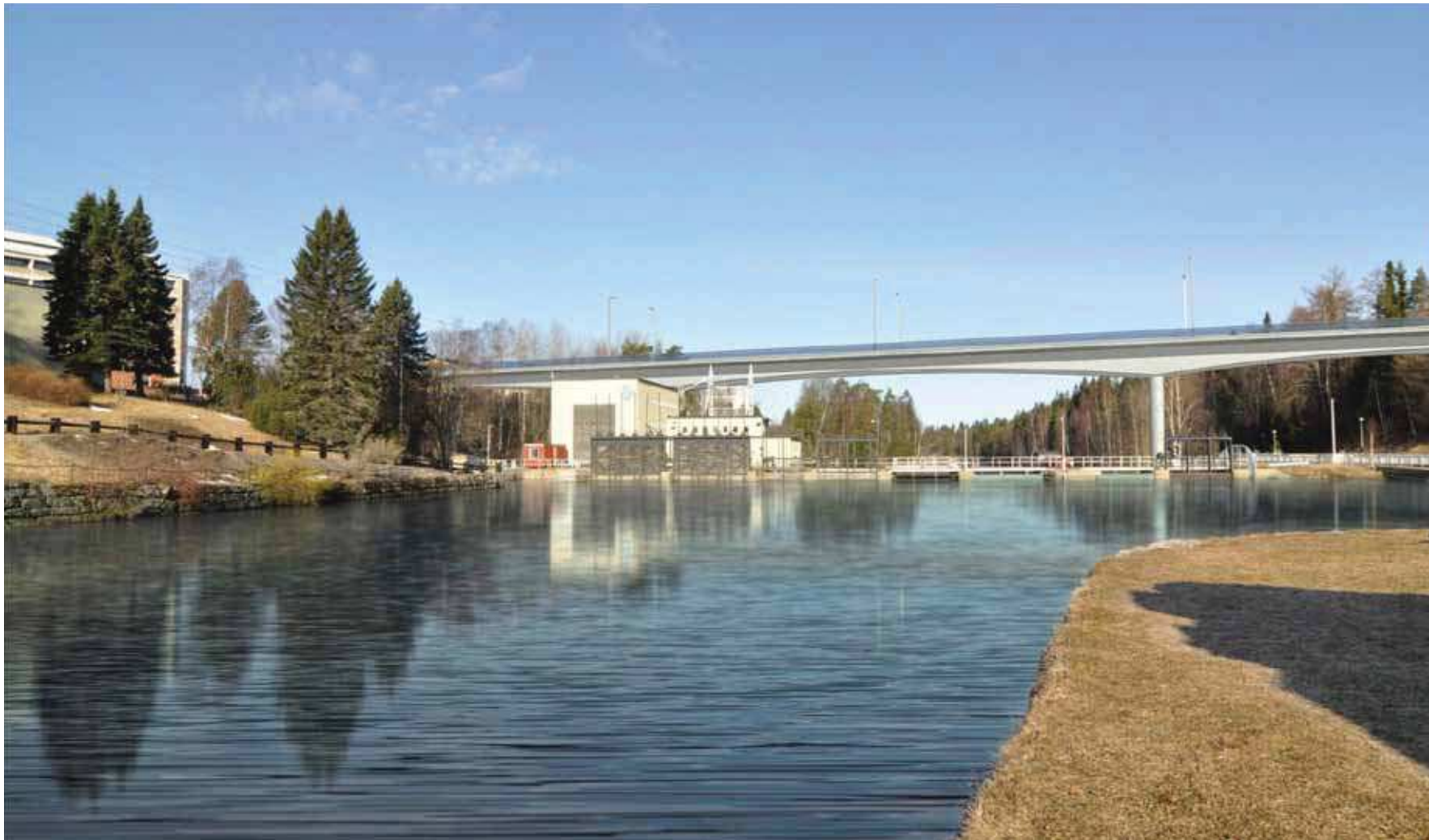
Liittorakenteinen jatkuva palkkisilta, jossa viisteellinen muoto. Perinteinen aukeahkojen vesistösiltaipaikkojen perusratkaisu.
